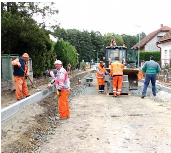
Foto z rekonstrukce ulic Mánesova a Topolová, kterou provádí pracovníci firmy SILMEX. Na snímcích probíhají práce na osazování obrubníků (Mánesova) a vyrovnávka podkladních vrstvy konstrukce vozovky (Topolová).
