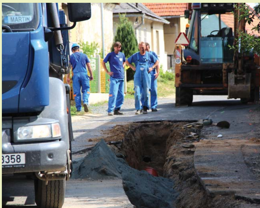
Pracovníci Vodohospodářské společnosti Vrchlice-Maleč, a.s., Kutná Hora při rekonstrukci kanalizace v Husově ulici.
